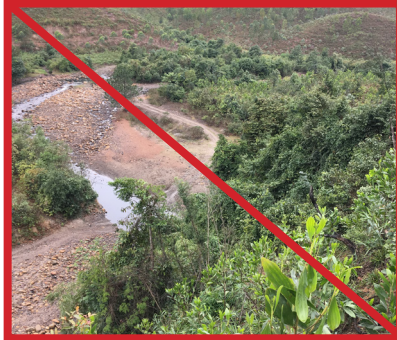
Đường vận xuất, vận chuyển qua suối; không có công trình vượt suối
